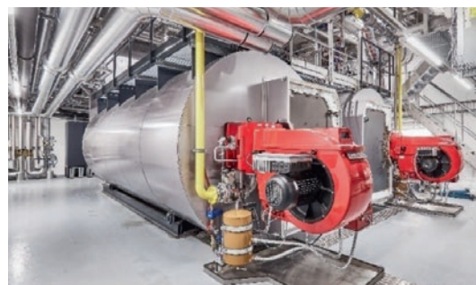
Wasseraufbereitungsanlage für Dampfkessel zur Erzeugung von Prozessdampf hochgereinigtem Wassers
